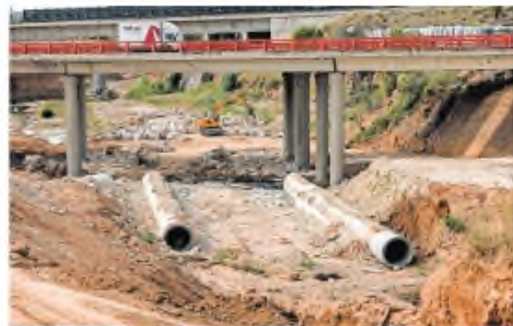
Reapertura ayer de la CV-36 sobre el barranco del Poyo. M. TORRES
